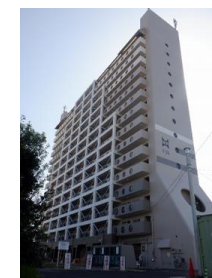
横塚台団地（令和2年度耐震改修実施）
