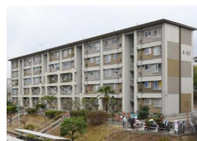
香里三井C団地（平成26年度耐震改修実施）
