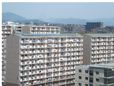
OPH北千里駅前（4号棟） ソーラーパネルの設置
