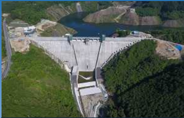
淀川水系 川上ダム（三重県）：新築
