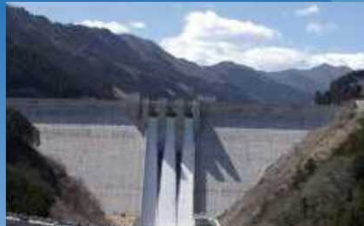
荒川水系 滝沢ダム（埼玉県）：管理
