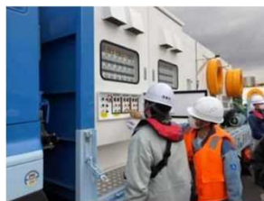
ポンプ車の操作訓練の様子
